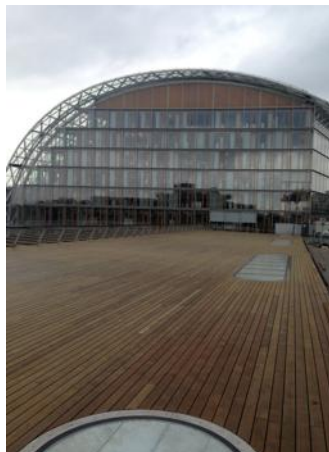
Le plancher de 1 600 m 2 ne comporte aucune vis. Une prouesse. DOCUMENT REMIS
